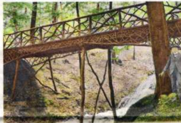
Mehrere solcher Brücken, wie hier auf einer alten Postkarte abgebildet, gab es einst im Mirker Hain.
